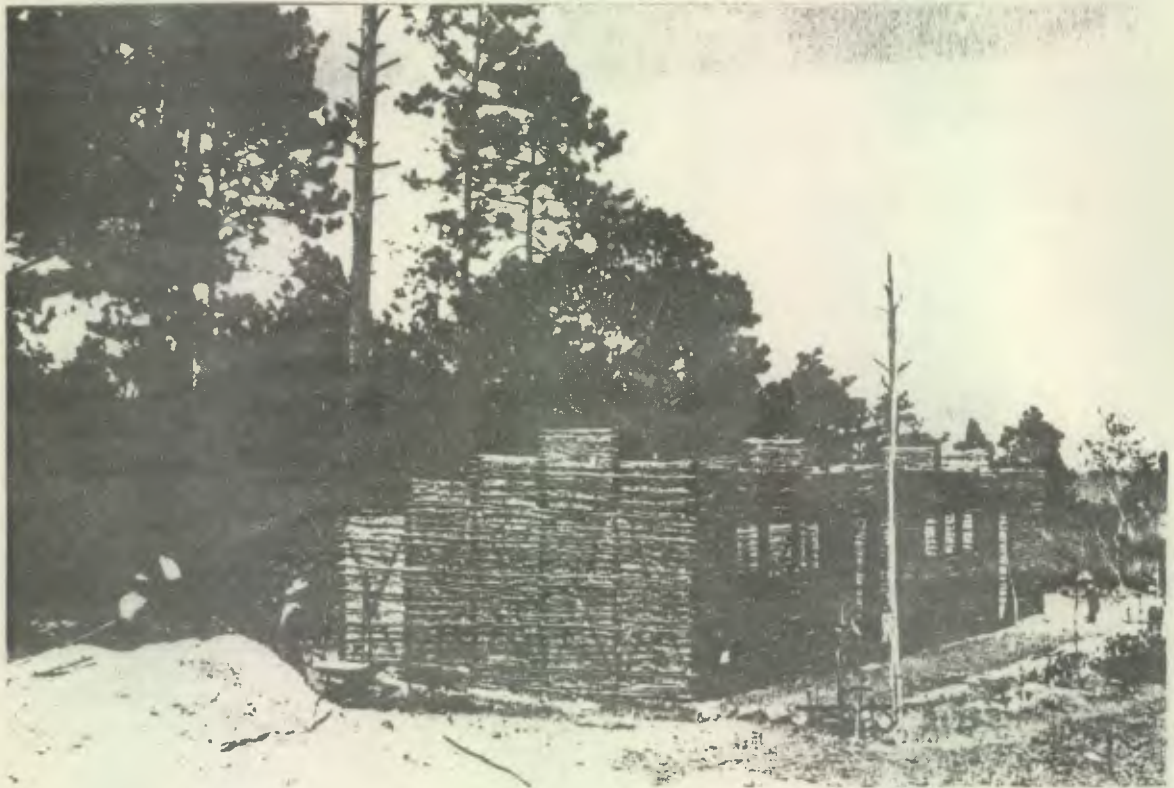
Se está colocando el barro, no se compacta debidamente, lo que hace que exista concavidades en el interior del muro. (Equipamiento, escuela La Lima).
