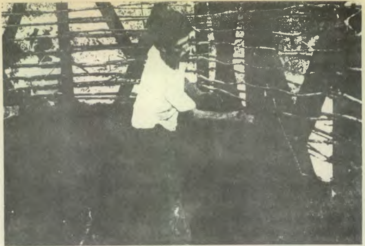
Se está colocando el barro, no se compacta debidamente, lo que hace que exista concavidades en el interior del muro. (Equipamiento, escuela La Lima).
