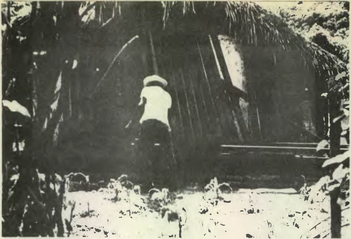
Curado de la madera, aplicado el curativo por medio de brocha, en forma de pintura, (curativo: pentaclorofenol, carbolíneo y diesel).
