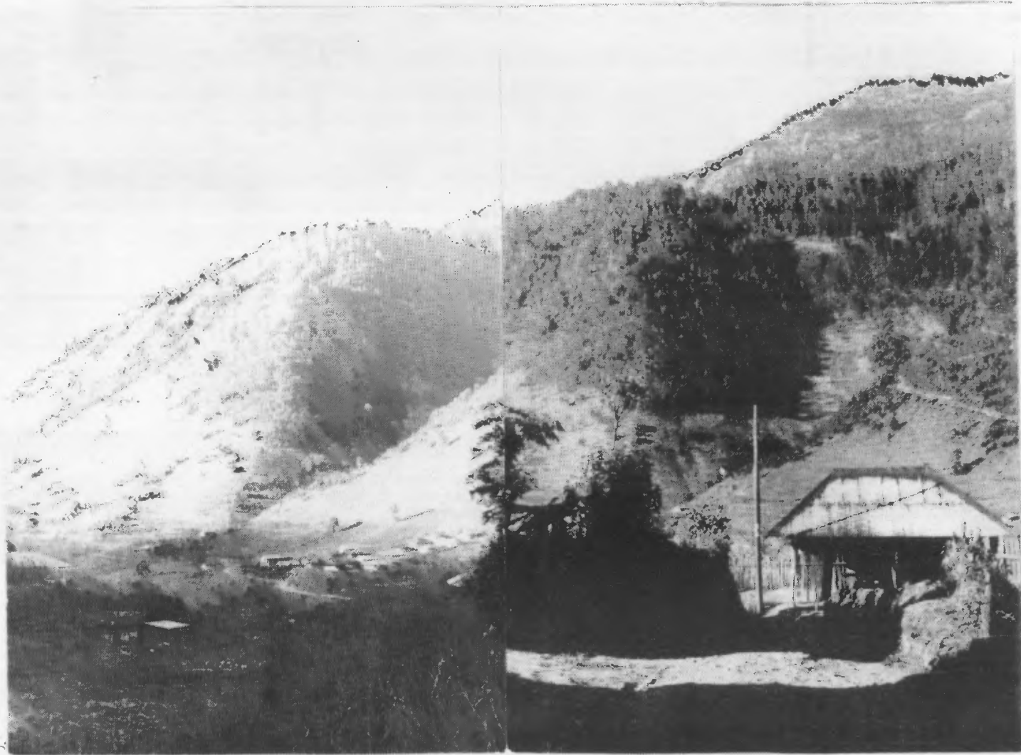
TODOS LOS SANTOS. Algunas viviendas varían por el uso de materiales en sus paredes y techos, no así la inclinación de éstos, que se conservan como algo típico del lugar, al igual que el sistema constructivo.
