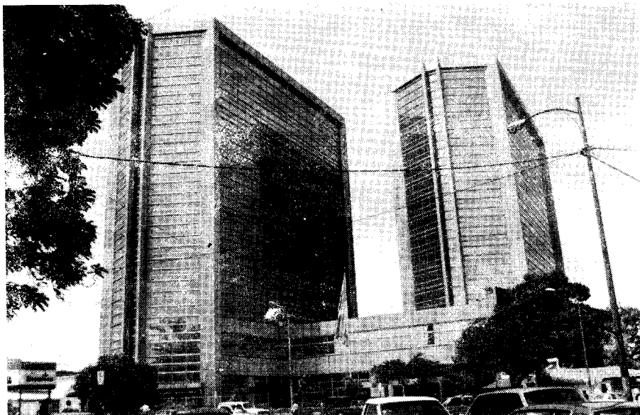
FOTO No. 29 TORRES CENTRO FINANCIERO 6A. AVENIDA ZONA 4 TARDOMODERNO
