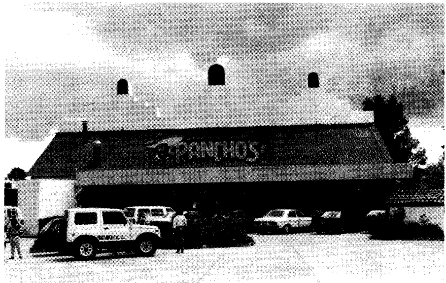
FOTO No. 24 RESTAURANTE LOS PANCHOS CALZADA ROOSEVELT ZONA 11 POSMODERNO
