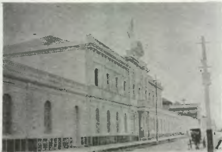
ADUANA CENTRAL DE GUATEMALA Foto Baixench, San José Costa Rica 1915 Fuente: Souvenir de la República de Guatemala en la Apertura del Canal de Panamá 1915, San José Costa Rica 1915
