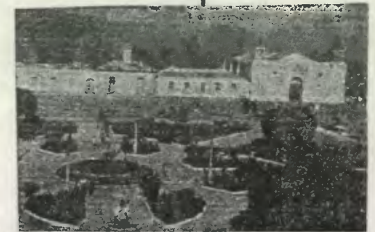
Nueva ubicación del Templo Construido de mampostería y techo de lámina de zinc. No se poseen datos de desarrollo arquitectónico.
