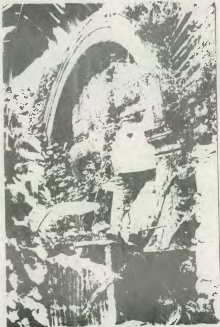
Vista del acceso de arco que posible- mente comunicaba a una capilla, ya -- que sus vestigios así lo indican. Actualmente se encuentra obstruida.
