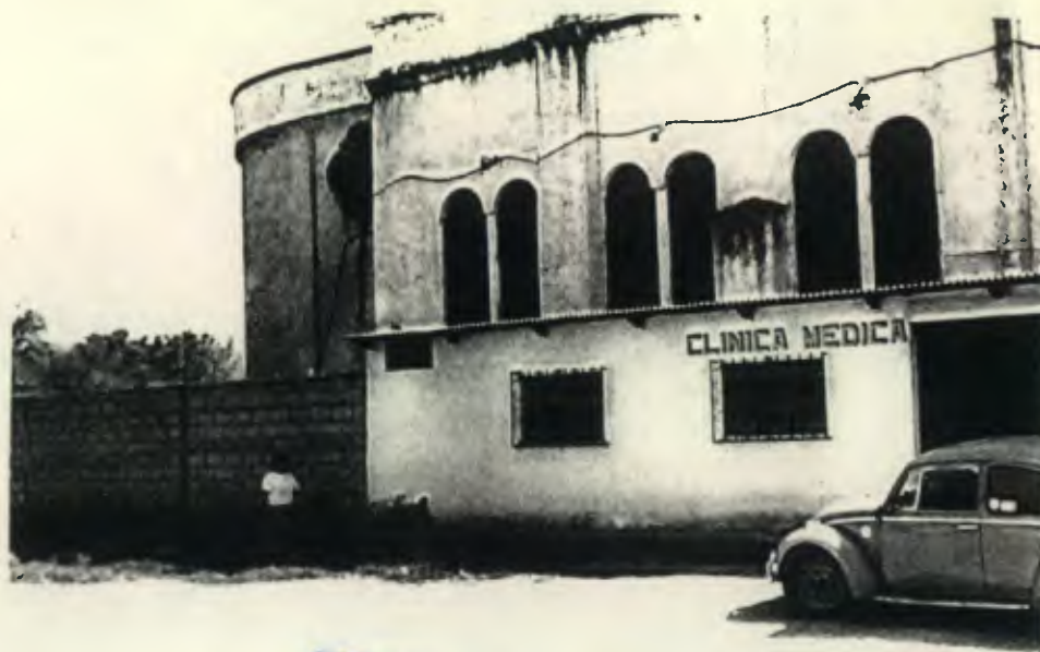
NÓTESE LOS CIMIENTOS DE LA ANTIGUA IGLESIA, DE DONDE SE LEVANTA LA ACTUAL.
