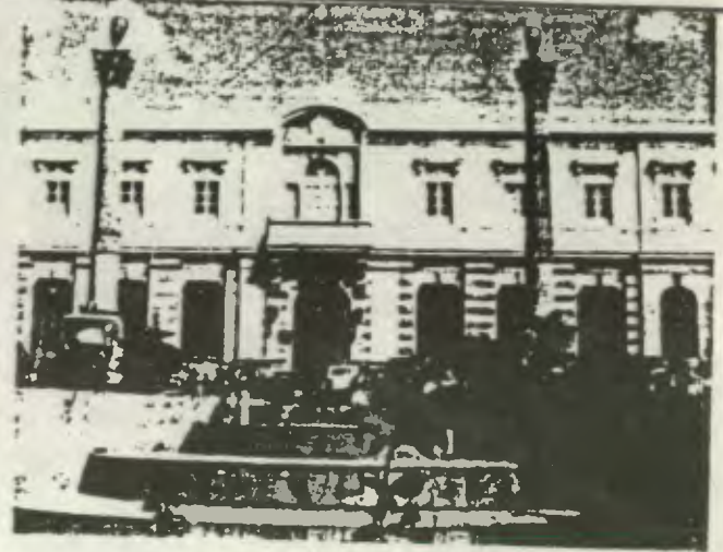
BANCO DE OCCIDENTE , Construido en 1881 por Carmen Rímola. Ubicado en el lado norte del parque, en la 4a. calle y 12 av. Propiedad particular, S. A.
