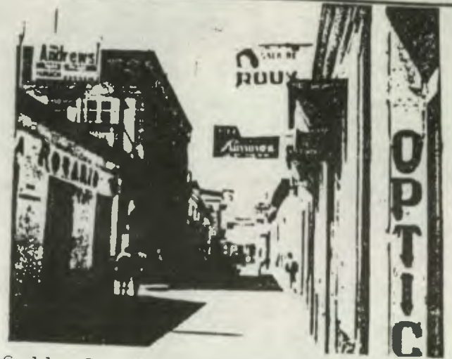
Calle Real del Calvario o 4a. calle, Proliferación de comercio, en la es- quina izquierda aparece el edificio de correos construido en 1914-15.
