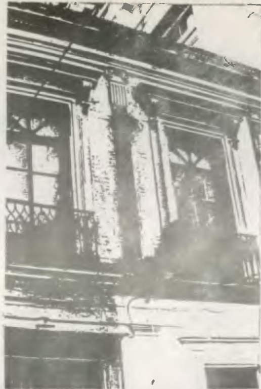
Foto No. 26 Fachada Estz Detalles
