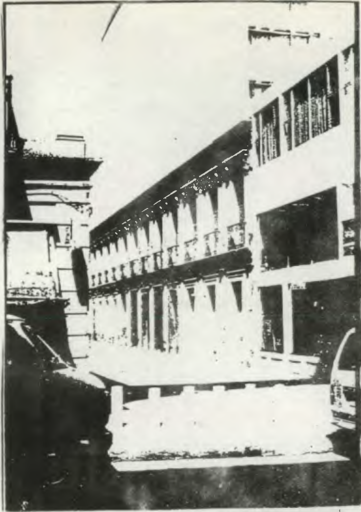
Foto No. 22 Fachada Sinistra
