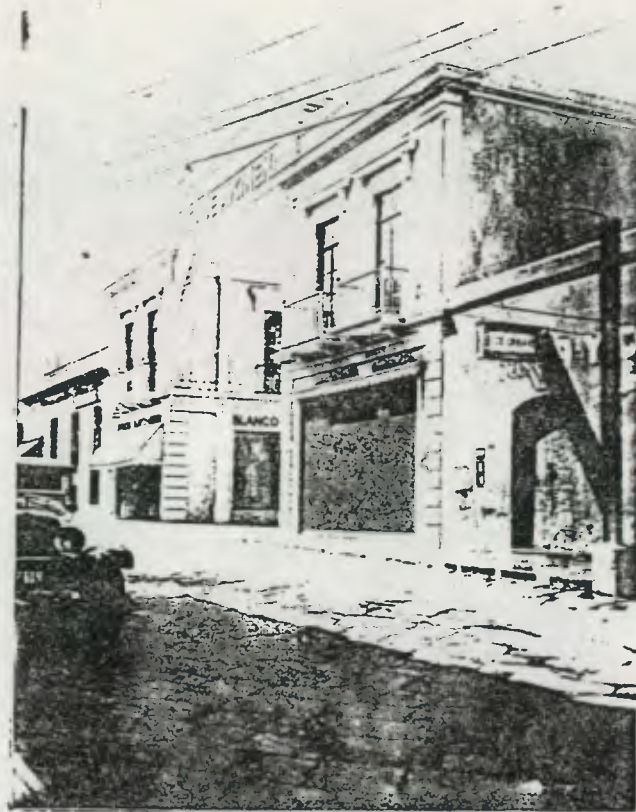
Fachada Sur en el año de 1931. 9a. calle zona 1. Antes de terremoto de 1917 - 1918.
