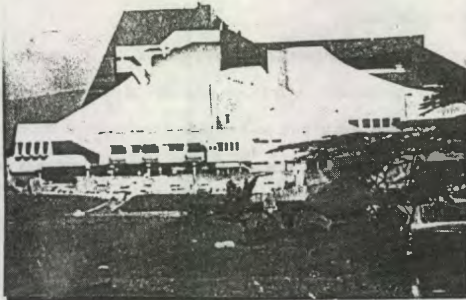
foto 18a. Fachada Este del teatro. (fuente: Arch. del T. N.)
