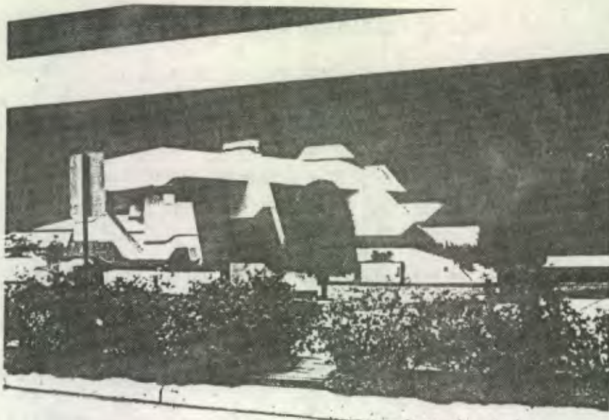
foto 24 Acceso hacia el teatro de cámara
