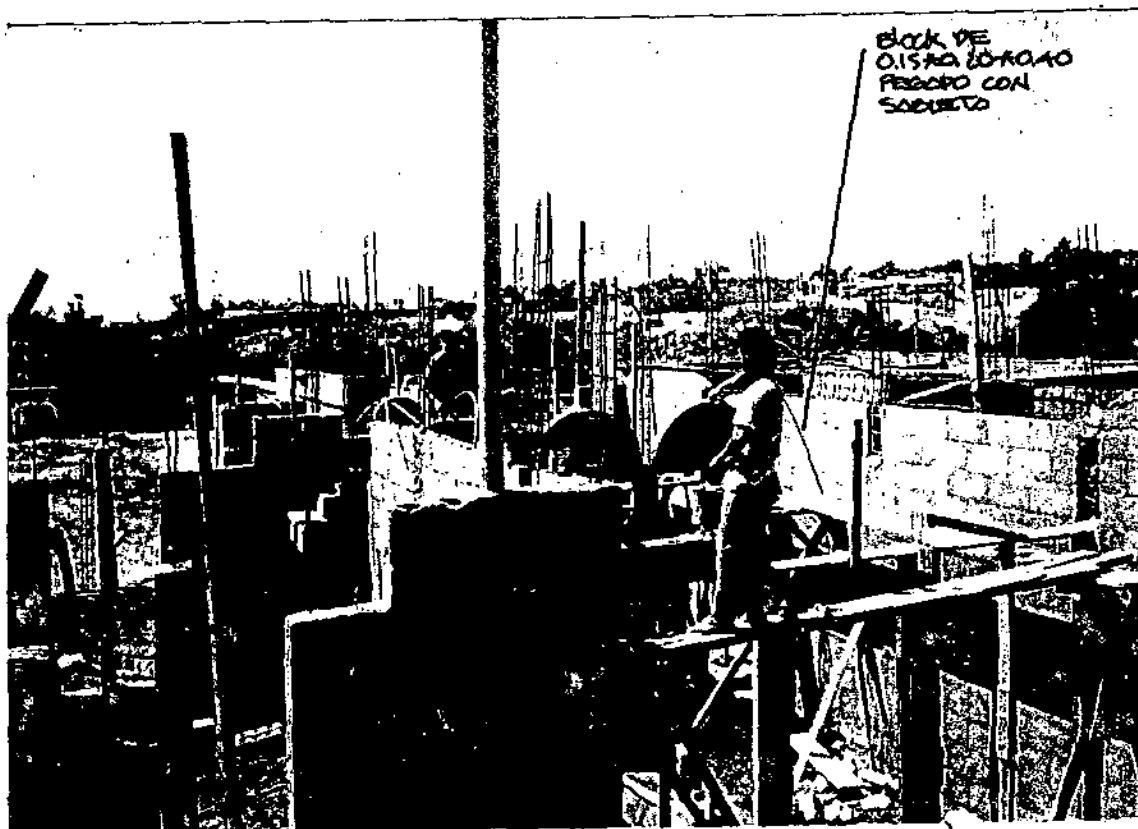
CONSTRUCCION DE UNA VIVIENDA DE MUROS DE BLOCK , EN LA COLONIA LAS LOMAS , ZONA 5
