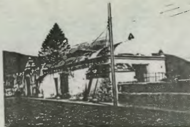
FOTO No. FACHADA PRINCIPAL. tomada del archivo de CNPAG, Mayo de 1,980
