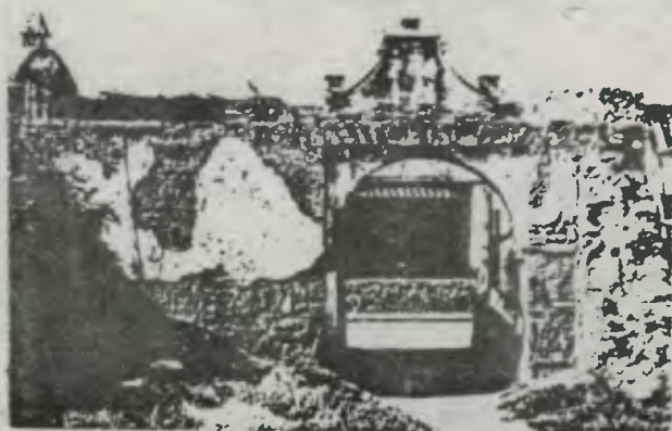
FOTO No. VISTA INTERIOR DEL INGRESO. Mayo 1991. Se puede observar los restos del acabado final original en paredes y el sistema constructivo.
