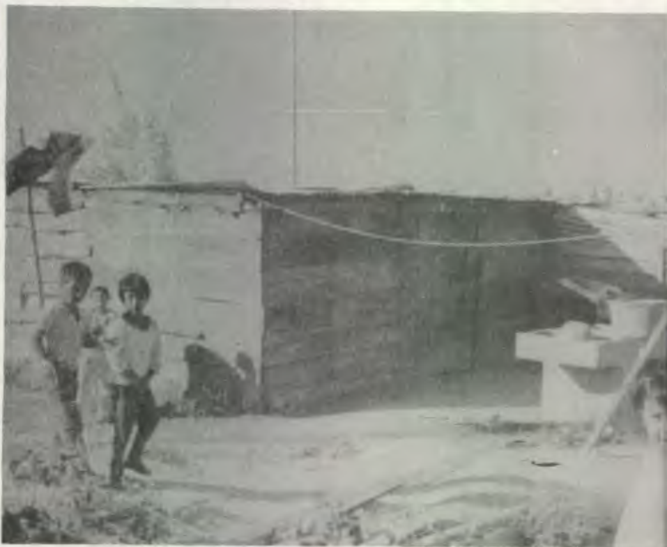
FOTO No. 11 AREA DE CONSTRUCCION DEL PROTOTIPO DE 3 DORMITORIOS
