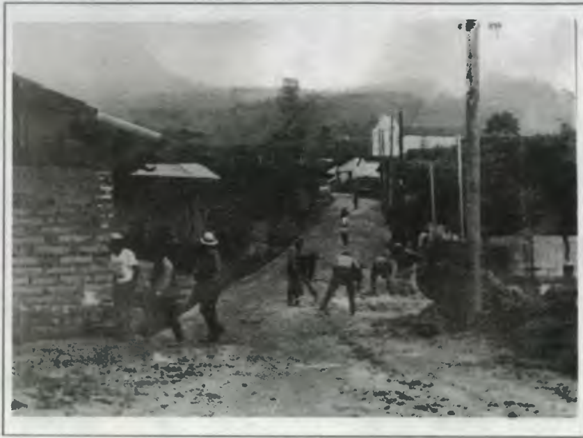
Fotografía No. 10 ESTADO ACTUAL
