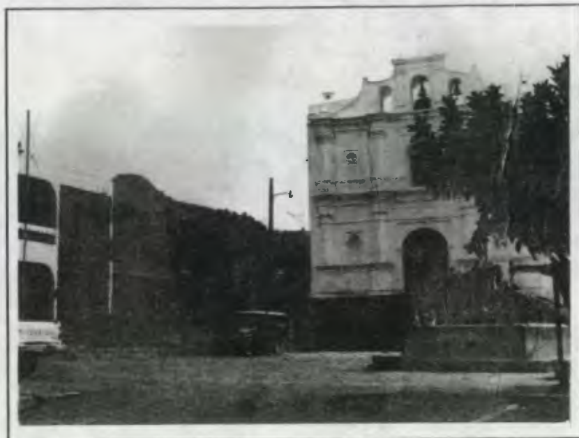
Fotografía No. 3 ESTADO ACTUAL
