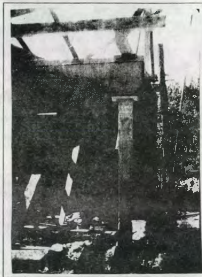
Vivienda vernácula en proceso de construcción
