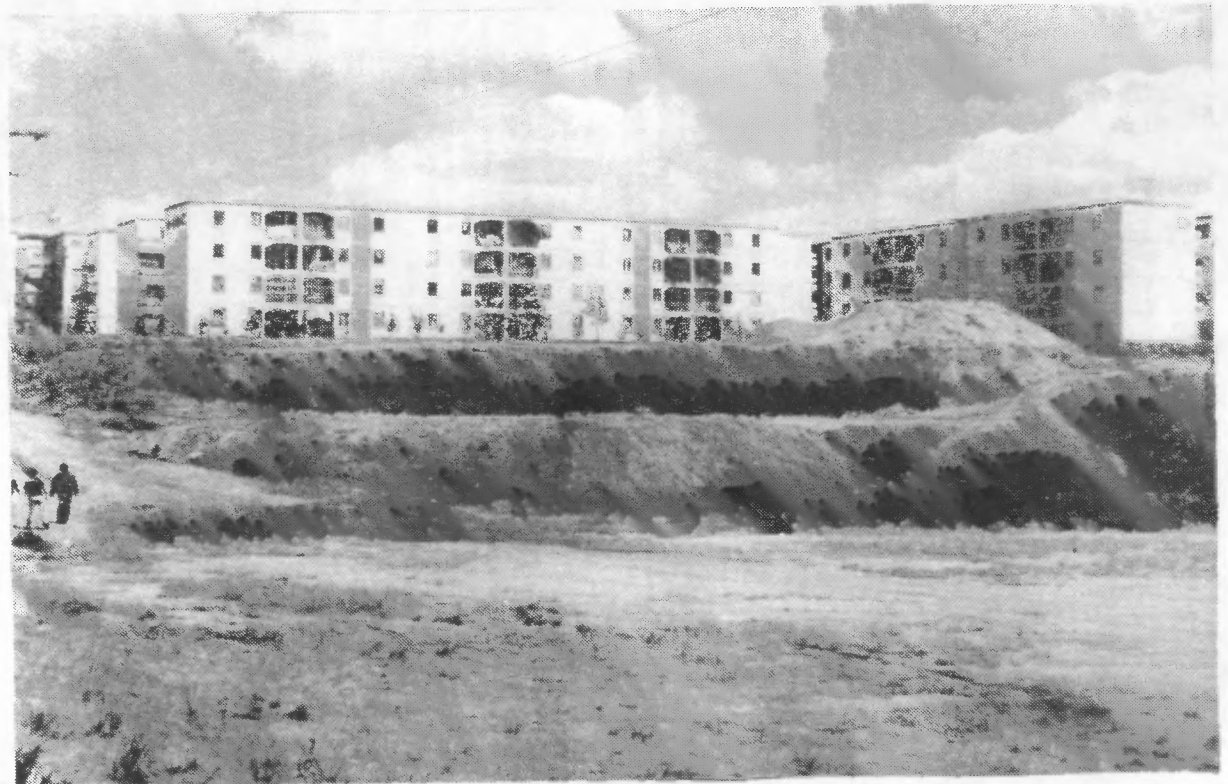
Foto 3: Vista de apartamentos, Proyecto Nimajuyú 1; observese al frente el Area Deportiva, con alto grado de descuido.
