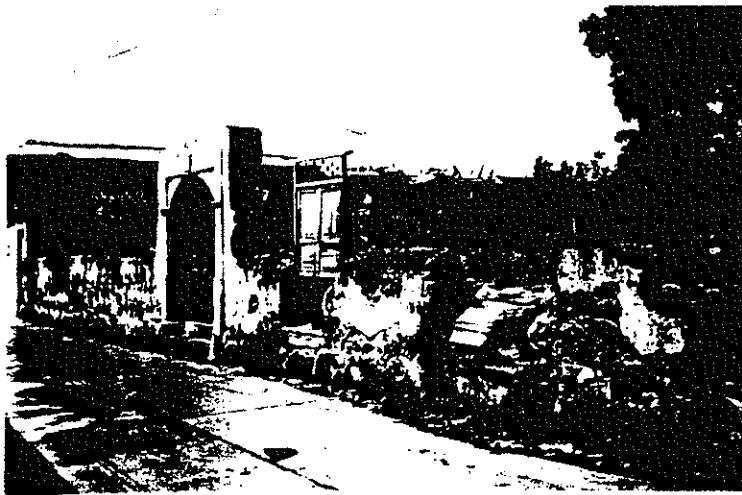
SE CAPTÓ UNA VIVIENDA DESAPARECIENDO OBSERVASE EL ARCO PARTICULAR DEL ÁREA DE MAZATENANGO. SE PUEDE CONOCER EL MATERIAL UTILIZADO CONSISTENTE EN PIEDRA Y ADOSBE. 2 PUERTAS DE INGRESO. NO POSEE BANQUETA. EL MARCO ESTA HECHO CON LADRILLO.
