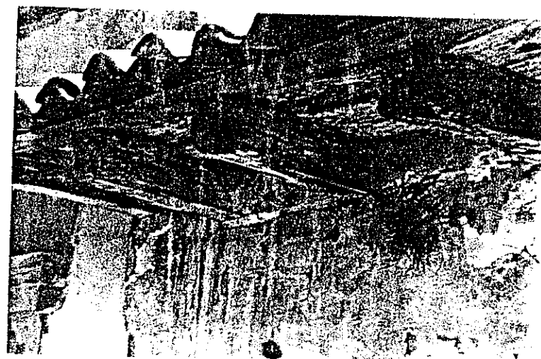
DETALLE DE DETERIOROS EN TENDALES DE ESTRUCTURA DE CUBIERTA Y MURO DE FACHADA.
