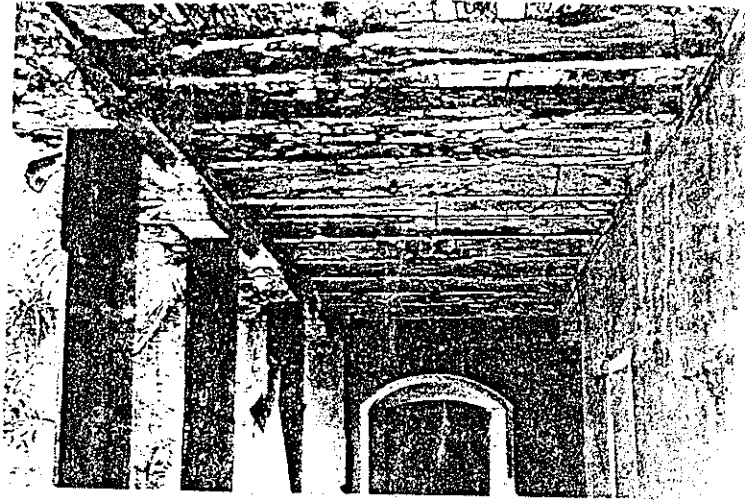
VISTA EN CORREDOR INTERIOR, Al fondo el vano de puerta clausurado. Deterioros en estructura de cubierta y faltante de acabados en muro.
