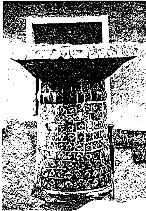
VISTA GENERAL DE LA FUENTE, Deterioros en su estructura faltante de materiales y humedad visible en algunas areas del piso de piedra.
