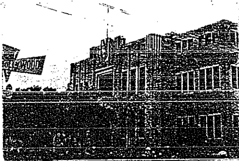
SANIDAD PÚBLICA (FACIADA PRINCIPAL) ING. MANUEL MORENO BARRAHONA 1935 3A. AVENIDA 14-65 ZONA 1
