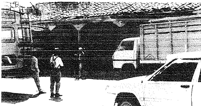
Fotografía No. 31. Portal del Comercio.
