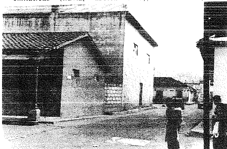
Fotografía No. 46. Fachada poniente.
