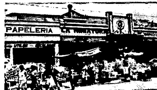
Ingreso Mercado No. 1, 4a. Avenida (Foto No. 11)
