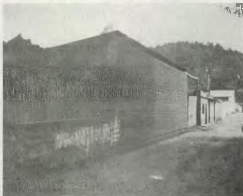
Fotografía 15: muro de adobe visto y cerramiento de caña. Fachadas con repellos y blanqueados.
