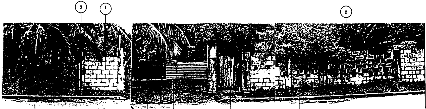
3a. CALLE LADO SUR
