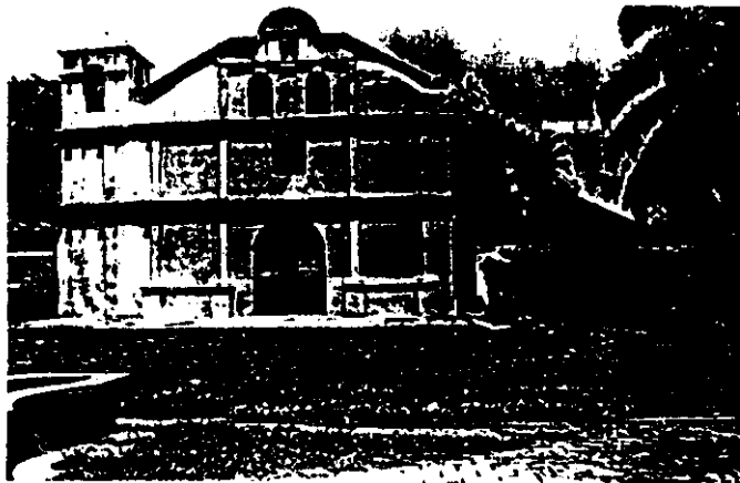
FACHADA: HUMEDADES Y ALTERACION CONCEPTUAL POR AGREGADOS POSTERIORES (DERECHA)
