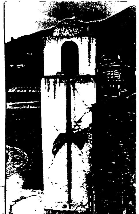
Fot.#10 VISTA DE LOS DANOS QUE PRESENTA EL CAMPANARIO EXISTENTE.
