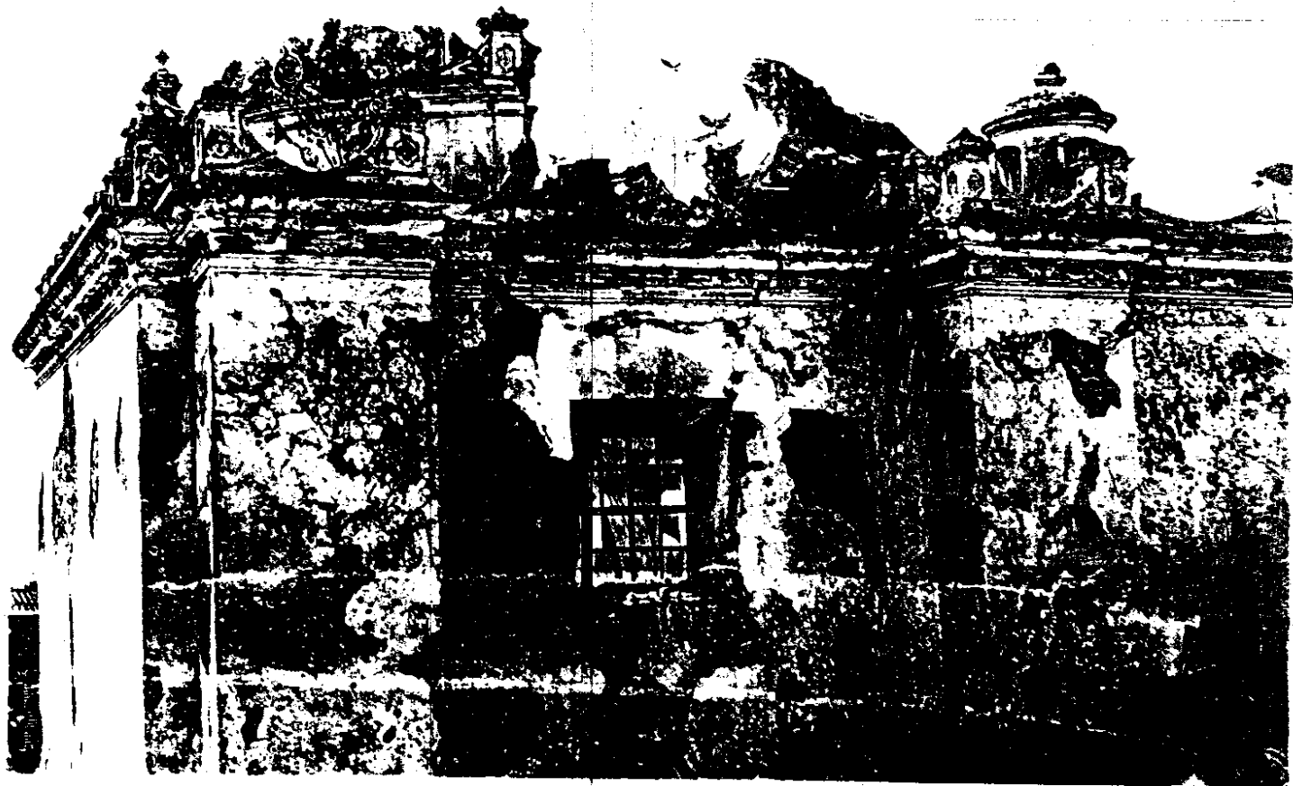
FOTO 11: MURO PONIENTE (Antes de consolidación reciente) DETERIORO: GRIETAS VERTICALES, PERDIDA DE REPELO DISGREGACION DE MATERIAL. PERDIDA DE LA CUPULA DEL ALTAR MAYOR. HUMEDAD Y CRECIMIENTO DE MACRO Y MICRO FLORA
