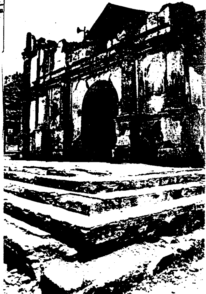
FOTO 12a: FACHADA PRINCIPAL (sur) DETERIORO: PERDIDA DE LADRILLO EN EL ATRIO, PERDIDA DE REPELLO EN LAS GRADAS.
