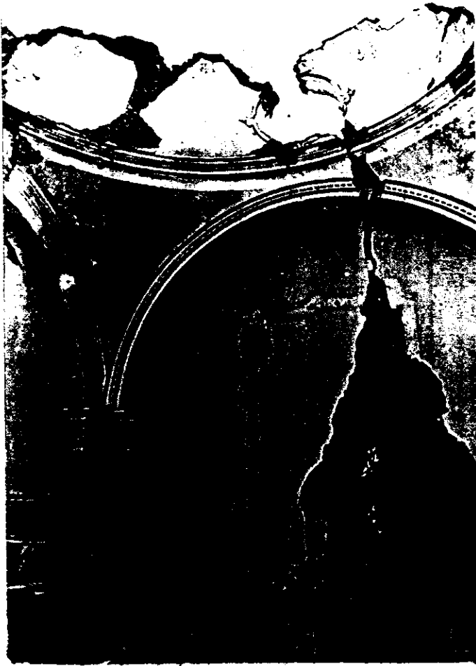
FOTO 15: VISTA DEL ALTAR MAYOR DETERIORO: FALTA DE LA CU- PULA, GRIETA VERTICAL, DIS- GREGACION DE MATERIAL.
