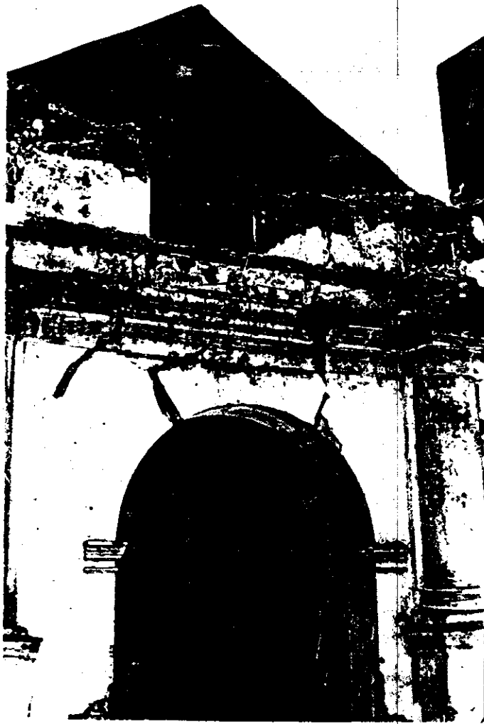
FOTO 12a: FACHADA PRINCIPAL (sur) DETERIORO: PERDIDA DE LADRILLO EN EL ATRIO, PERDIDA DE REPELLO EN LAS GRADAS.
