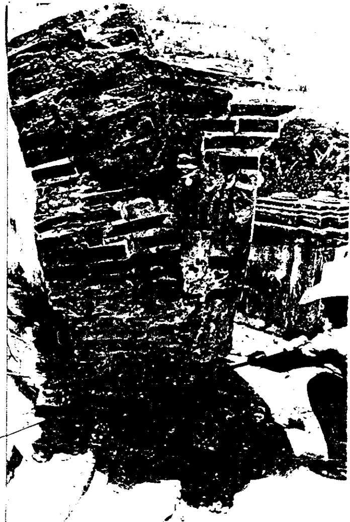
FOTO 16: RESTOS DE LA BOVEDA DEL ALTAR MAYOR. DETERIORO: HUMEDAD, CRECIMIENTO DE MACROFLORA
