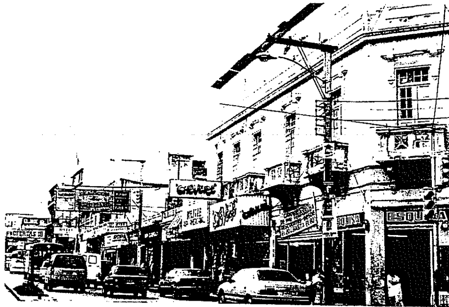
Vista de la 18 calle hacia el nororiente. Alta conta- minacion visual por rotulos comerciales, cables aereos, diversidad de materiales.
