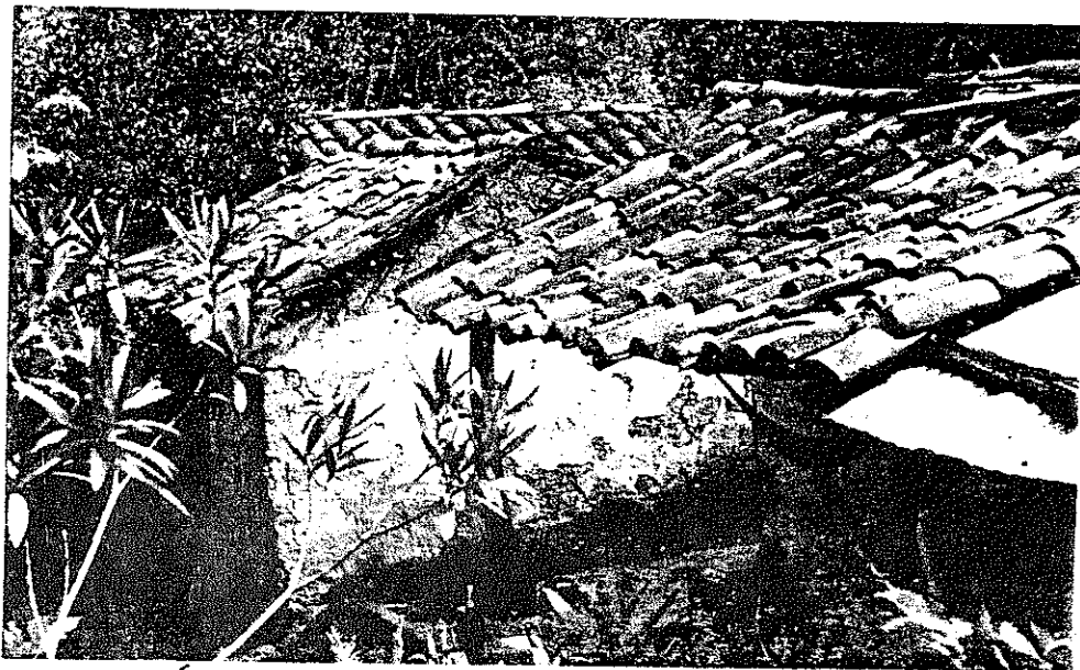
FOTOGRAFÍA. FACHADA FRONTAL.
