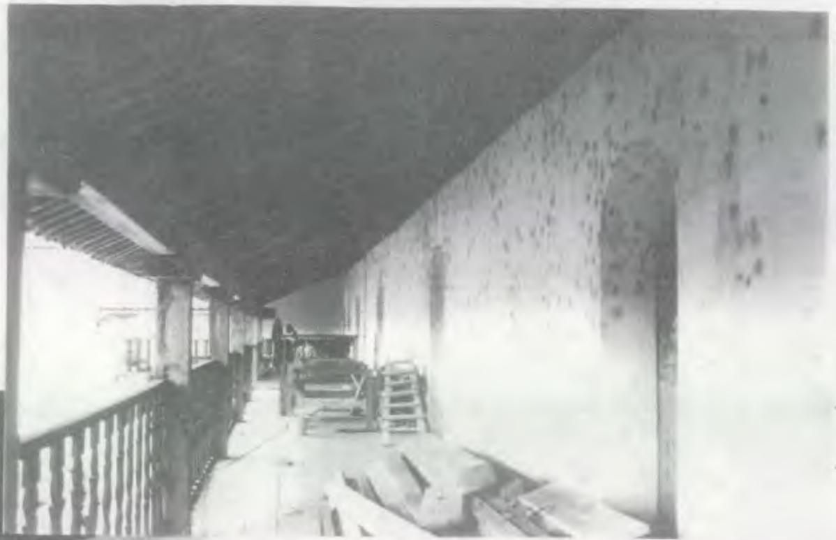
**FOTO No. 18** Vista interior del corredor Oeste del segundo nivel, vemos el nuevo artesón del corredor sobre los muros manchados por murciélagos.
