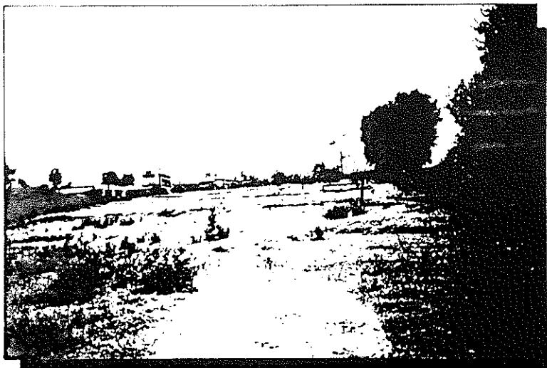
FOTOGRAFIA 1 No. 3 VISTA AL SUR
