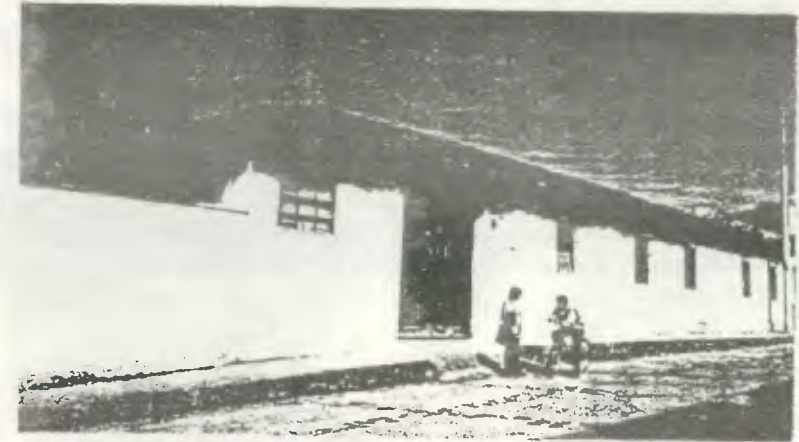
Casa 7a Ave 2-11 zona 1
