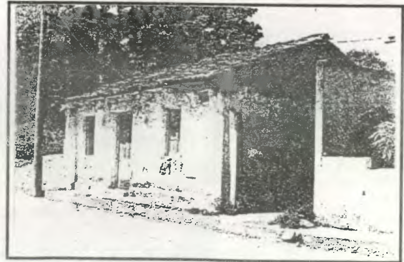
Casa de la 3a. Ave.-2a. Calle z.1 Demolida totalmente, estando en pésimo estado. Actualmente, existe un Lavado de Carros.
