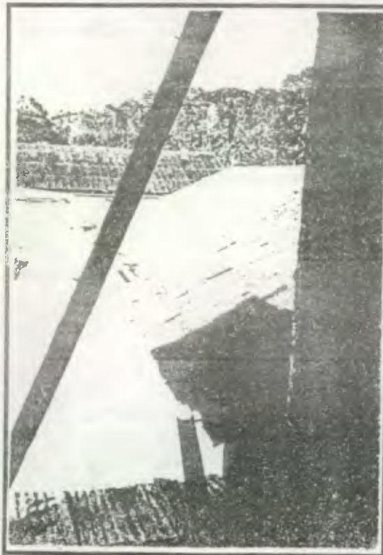
Foto Izq. Vista del muro norte derrumbado. Al fondo la Cubierta de Teja de la Parte Baja.
