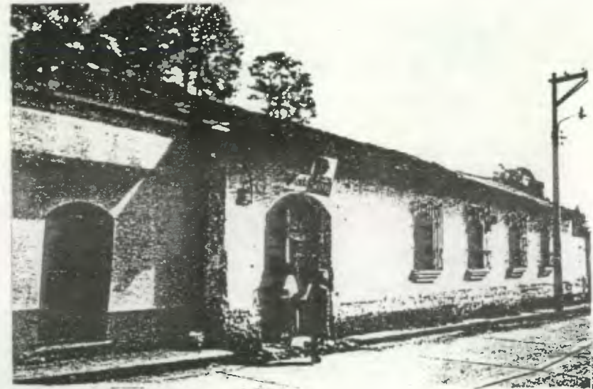
Casa 3a. Calle 2-11 zona 1. Tipo Colonial de 1940.
