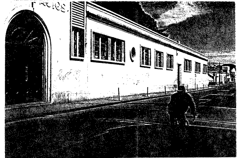
FOTO No. 34. Vista sobre la 11 av., notese la diferencia en sus caracteriscas constructivas.
