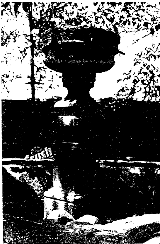
FOTO No. 41. Detalle de Fuente ó Pila Colonial.
