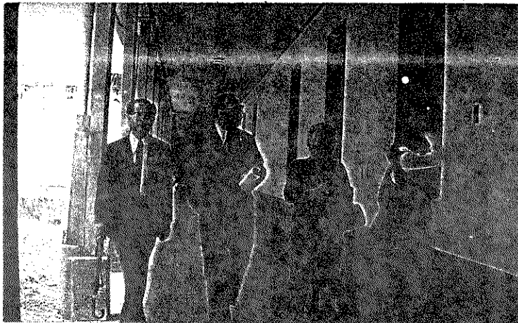
FOTO No 21. 1965, Se aprecia pasillo de aulas en el area antigua del edificio.
