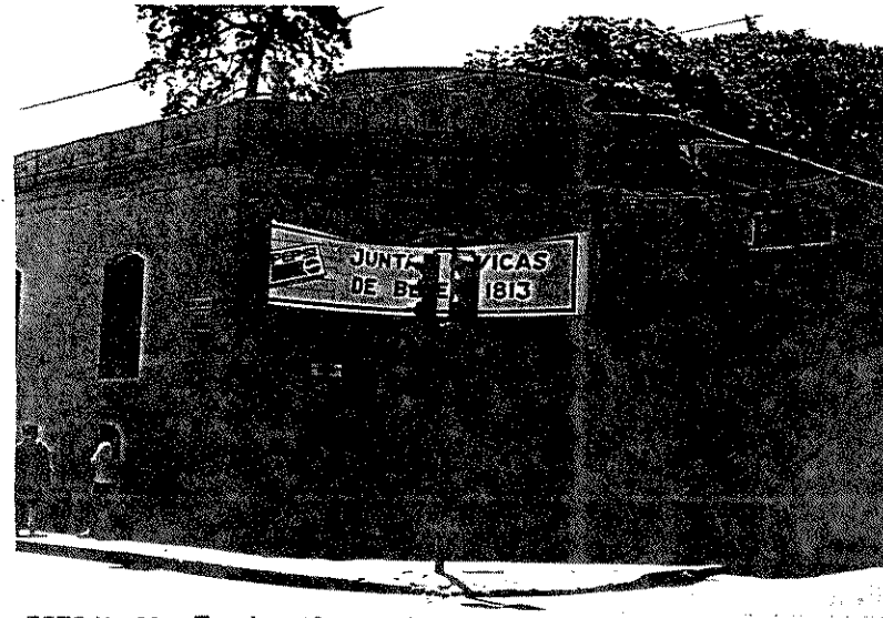
FOTO No. 38. Esquina, 10 av. y 12 calle, antes ingreso principal al edificio.
