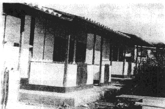
Viviendas construidas con muros de quincha peruana en el municipio de Ixcán, departamento de El Quiché.
