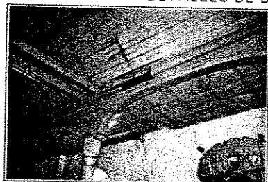
DETALLES DE DANOS EN MADERMAN DEL CIELO SUSPENDIDO
