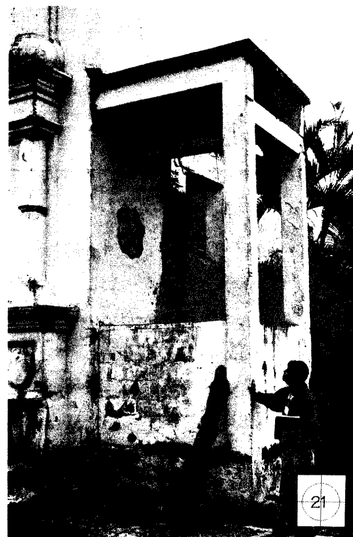
21. Agregado construido con concreto reforzado y block de pómez en la parte inferior, que funciona como campanario.
