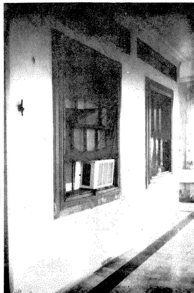
• APARATO DE AIRE ACONDICIONADO PROVOCANDO HUMEDAD EN EL MURO
