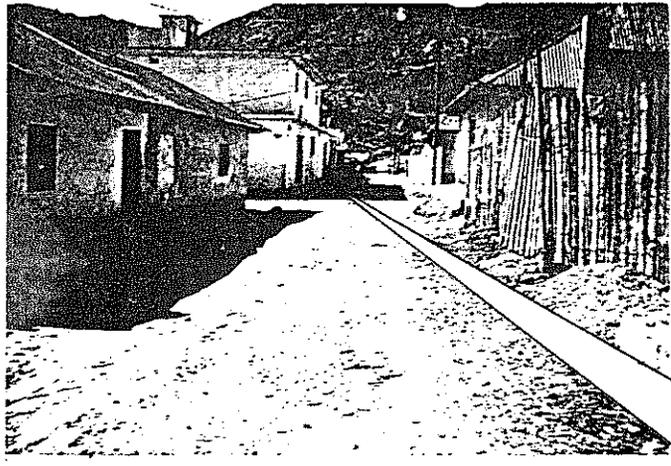
Foto No. 5. Se conserva el tipo de techo inclinado de cuatro vertientes, el predominio de lámina de zinc, excepto la vivienda de dos plantas que altera el esquema formal en esta calle. En ambas construcciones se descartó el adobe.
