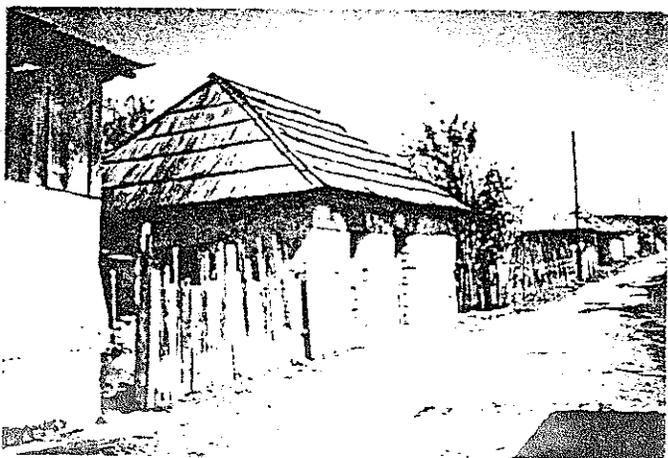
Foto No. 2 Vivienda construida con adobe repellado y techo de teja manil de cuatro vertientes (ver planta y sección en esta página); actualmente ambos materiales no se usan y en su lugar el block y la lámina de zinc o losa de concreto reforzado respectivamente. Una característica particular de éstas es que la cocina se construyó aislada e independiente de los demás ambientes. En las fotografías, de la N.4 en adelante, los ambientes integran un solo bloque.
