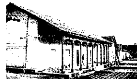
FIG. 9 VIVIENDA EN PROCESO DE CONSERVACIÓN POR EL PROPIETARIO
