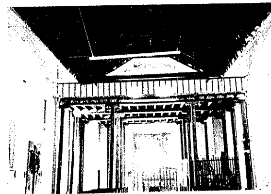
DETALLE INTERIOR DEL TEMPLO
