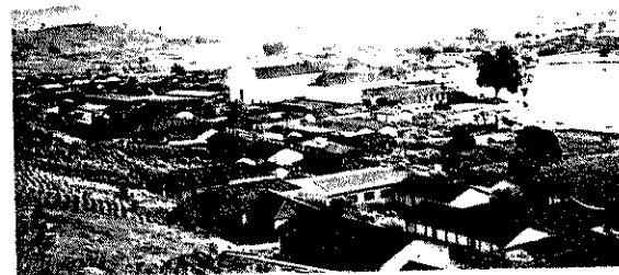
FIG. 1 POBLADO EN CONJUNTO, NÓTESE EL TEMPLO Y CONVENTO
