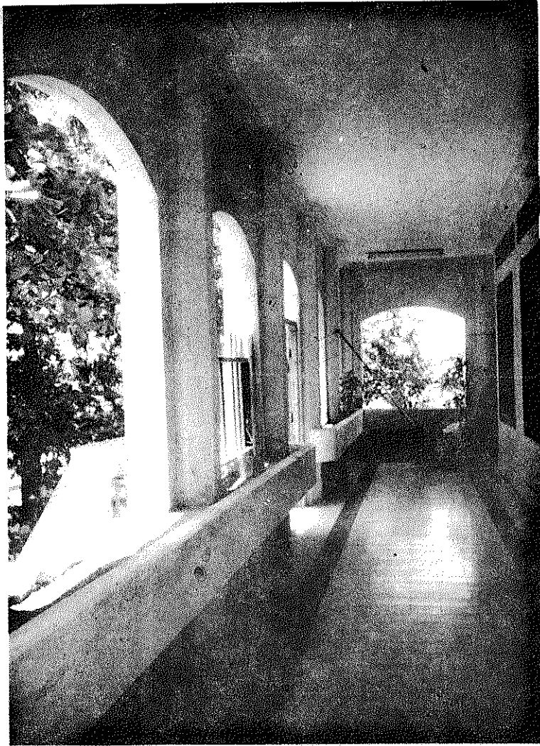
• SEGUNDO NIVEL • PASILLO PERIMETRAL
