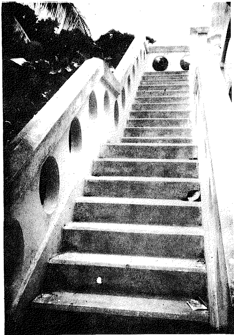
• ESCALERA QUE CONDUCE HACIA LA AZOTEA
