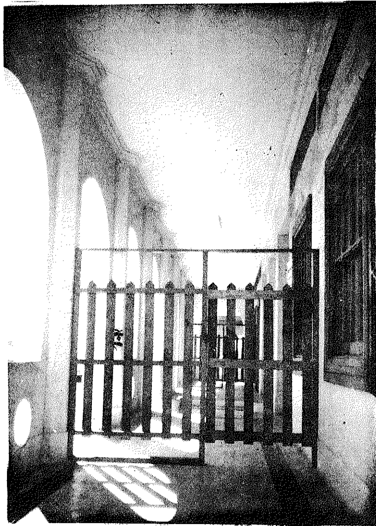
• PRIMER NIVEL BARANDAS IMPIDEN CIRCULACION
