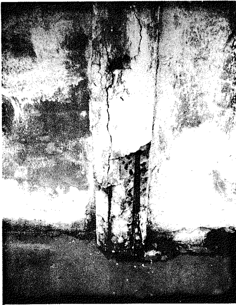
• DESPRENDIMIENTOS EN REMATES DE COLUMNAS
