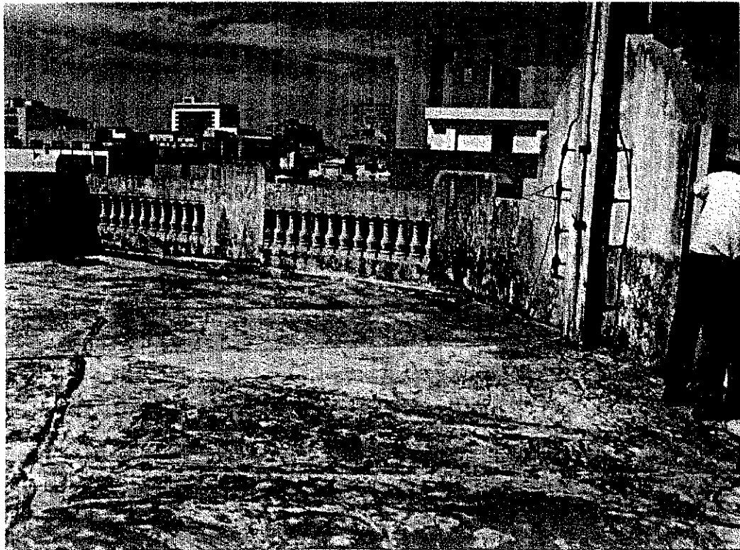
Foto 21. La terraza de la sala de sesiones presenta grietas, fisuras y humedades
