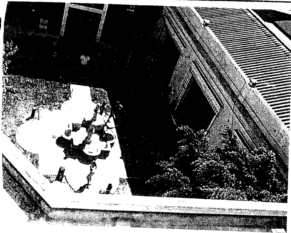
Foto 17. Vista de uno de los patios, la baldosa de barro cocido tiene humedades, grietas y fisuras.
