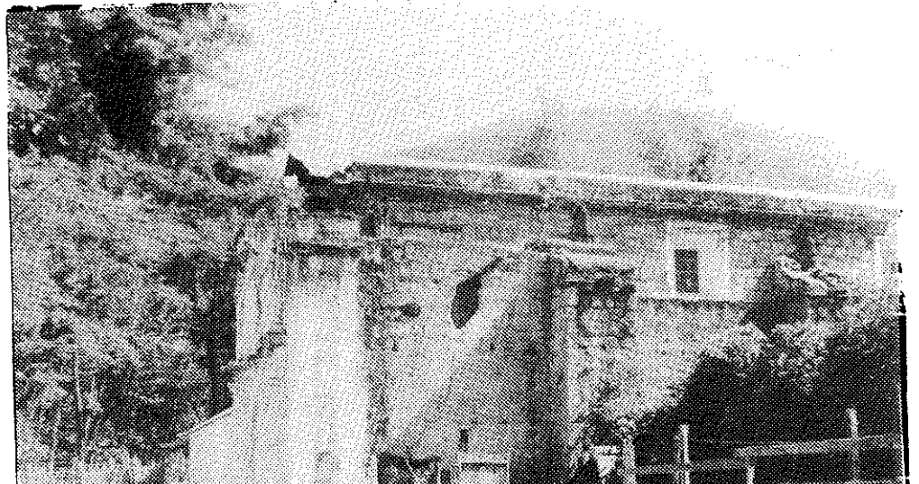
FOTO N.4 Vista lateral del templo después del terremoto de 1976. FUENTE: CNPAG
