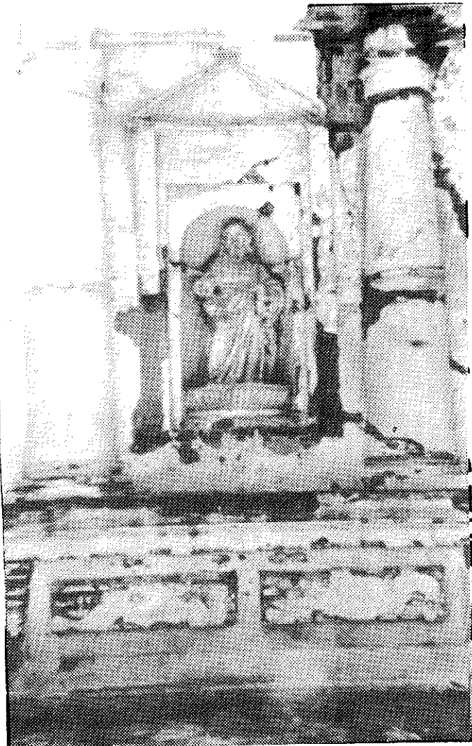
FOTO N.15 Desprendimiento de acabados, presencia de grietas y fisuras en la pilastra y nicho lateral sur del primer cuerpo de la fachada.
