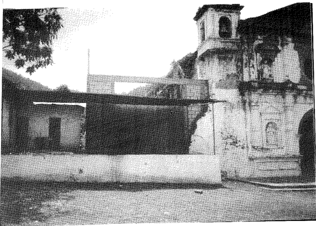
FOTO N. 37 Estado actual de la construcción del salón-bodega junto al templo, el cual fué aprobado por el CNPAG.
