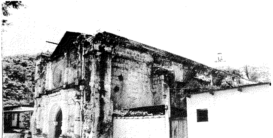
FOTO N.12 Vista lateral en donde se muestra el estado de deterioro de la fachada
