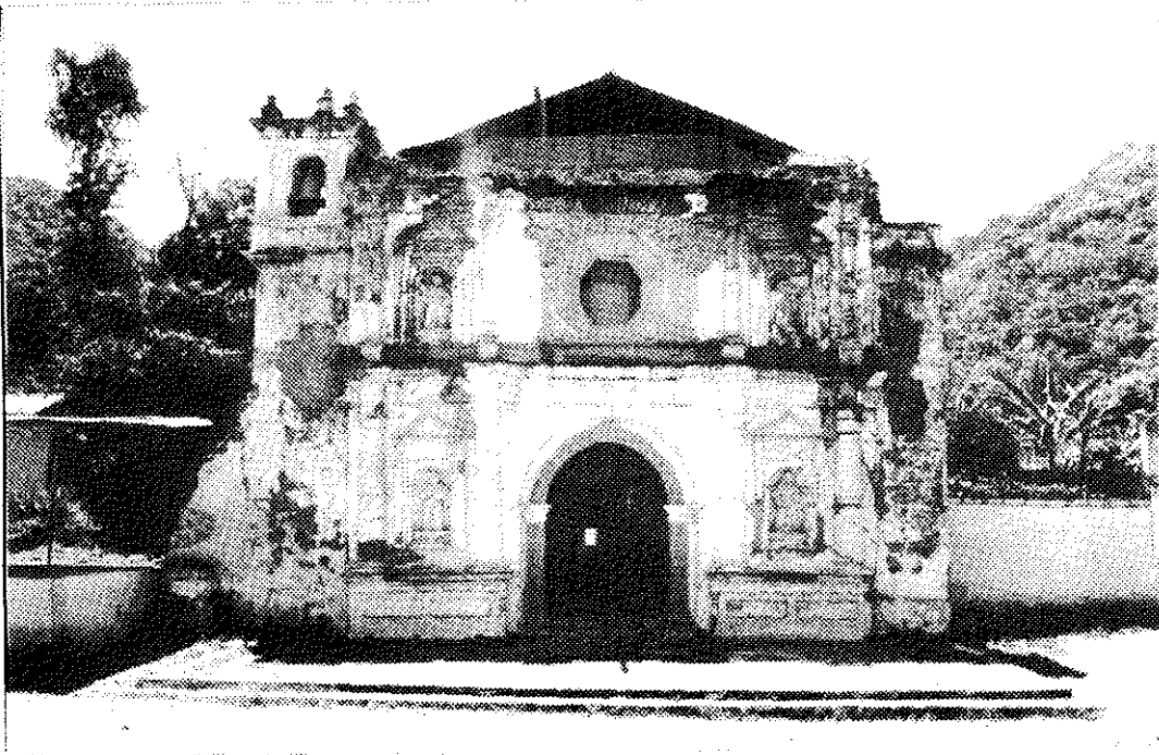
FOTO N.11 Estado actual de la fachada que muestra diferentes tipos de deterioros a lo largo y ancho de la misma.
