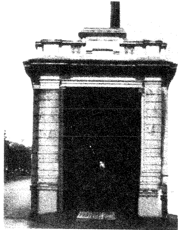
Fachada oeste del Portal del Comercio Propuesta de intervención Fuente: Fotografía tomada por el autor Sin escala
