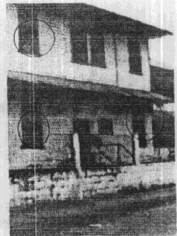
Faltante de vidrio en ventanas y madera en muro
