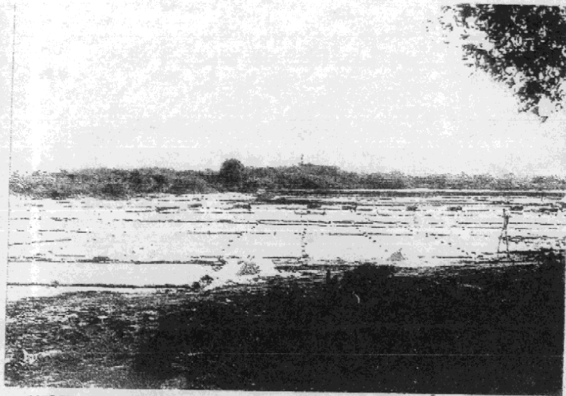
VISTA AL NOR-ESTE SECADO DE SAL EN CAMINO DE INGRESO A CHURIRIN (COLINDANCIA CON Laguna Chiquistepeque)
