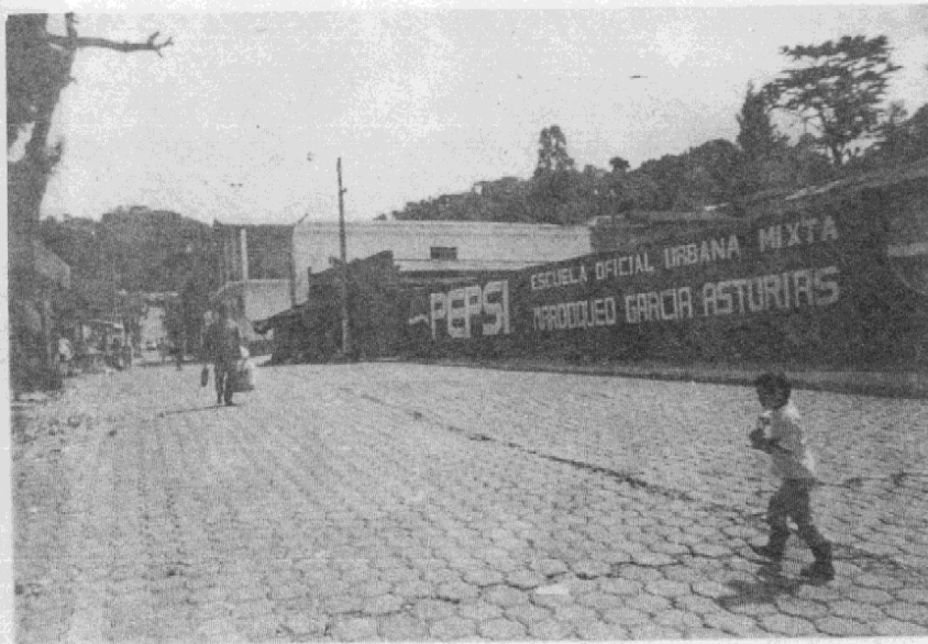
FOTOGRAFIA No. 3: Acceso vehicular No. 2, muro perimetral de escuela oficial mixta Mardoqueo García Asturias. Sistema constructivo de block y cemento.
