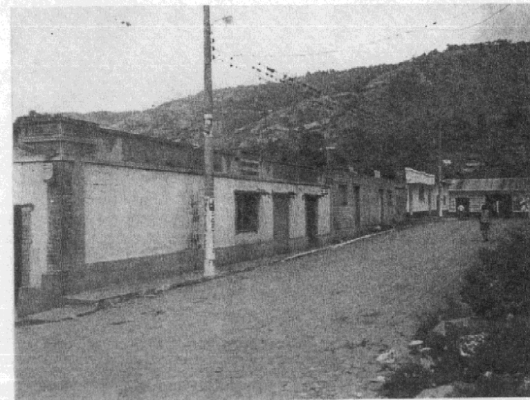
FOTOGRAFIA No. 4: En primer plano tenemos vivienda- comercio, sistema constructivo de ladrillo y adobe. Al fondo se observan viviendas con sistema constructivo de block y cemento, cerramientos de ventanas y puertas de metal.
