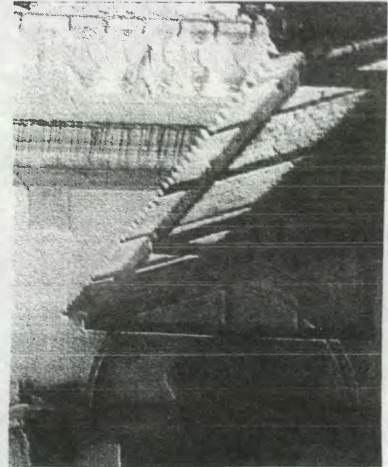
**FOTO N° 38** Agregado con lámina plástica verde, para evitar la lluvia, se puede observar la humedad en la pared y capitel de la columna.
