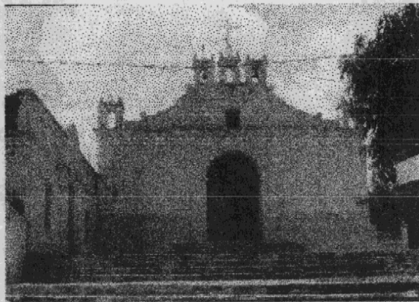
Fotografía No. 7 Templo del Calvario, Rabinal, Baja Verapaz Fuente: fotografía tomada en septiembre de 1999
