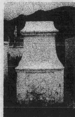
a. Propietario: Familia Perdomo b. Tipo de edificio: Mausoleo c. Época de construcción: finales del siglo XIX
