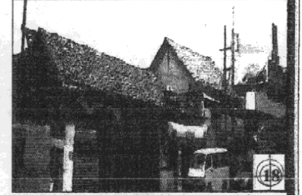
Vista del área comercial al lado norte del parque la Unión (donde construyen locales comerciales)
