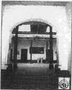
Ingreso principal al edificio Municipal, al fondo, en la parte superior Se puede apreciar la cubierta de lámina con una armadura de madera adosada al edificio, contrastando totalmente con el mismo
