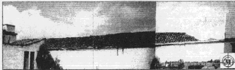
Vista del patio del Convento, al fondo el techo de teja del edificio de la Municipalidad
