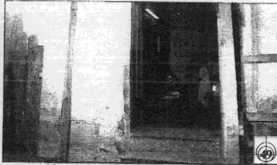
Vista del ingreso secundario al edificio (algunos deterioros y alteraciones)
