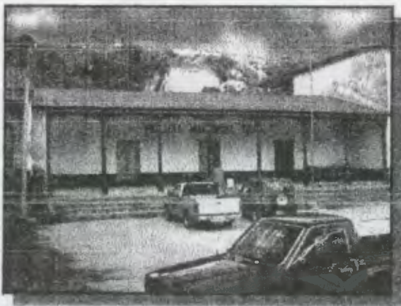
Edificio de la Policía Nacional Civil
