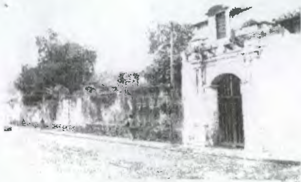
Muro perimetral “Convento de Santa Clara”
