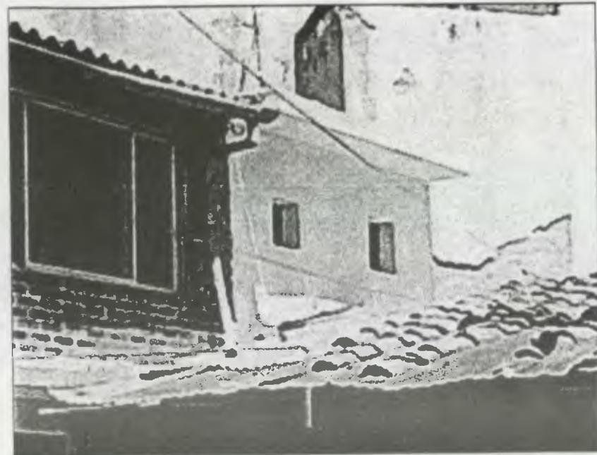
Se aprecia el marcado deterioro del repello en la parte posterior de la parroquia, también la falta de unificación en los materiales de construcción empleados tanto en los muros, como en el techo.
