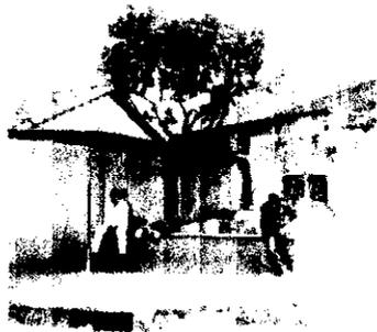
Pila Pública ubicada en la Calle Real y 10ma. Avenida de la zona 3. Construida de ladrillo y cubierta de alisado de cemento. La cubierta de lámina de cinc y estructura de hierro galvanizado es de construcción reciente.
