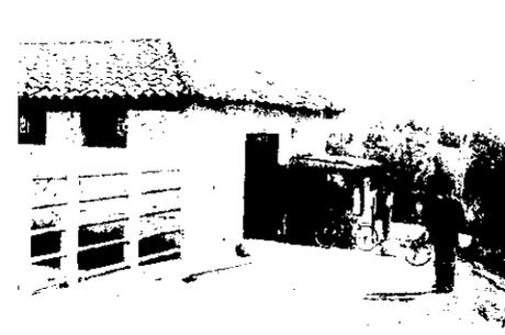
Rastro Municipal de la Villa de Chiantla, ubicado al final de la Calle Real. Fue construido en el año de 1928.<sup>40</sup> Posee un estilo arquitectónico vernáculo, utiliza sistema constructivo y materiales tradicionales, propios de la región como adobe para los muros, madera en la estructura de techo y cubierta de teja de barro cocido.
