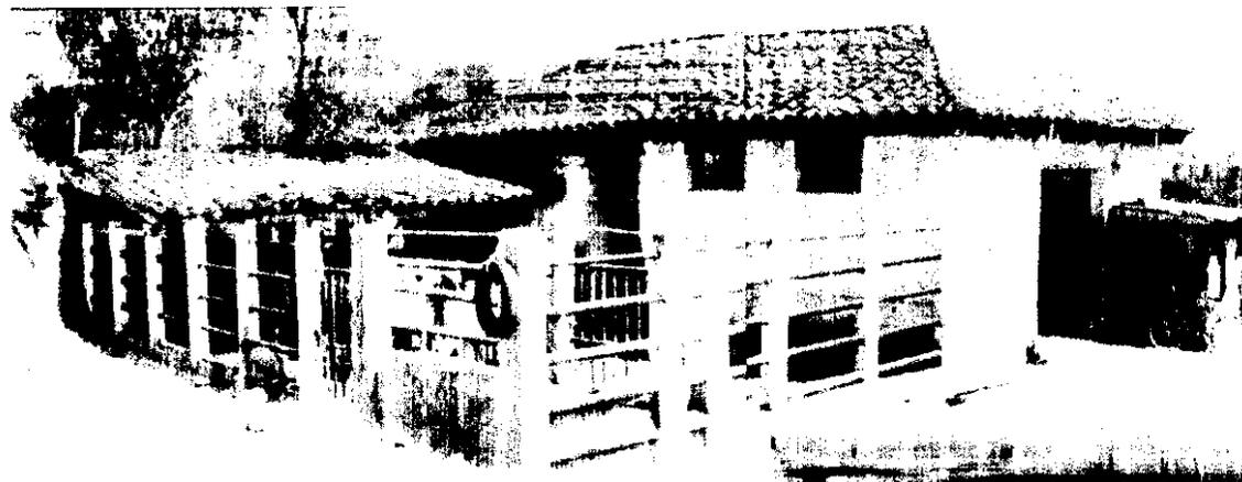
Foto del Rastro Municipal de la Villa de Chiantla tomada en el año de 2000. Se observa que la cubierta de teja del Toril fue sustituida por lámina de cinc.
