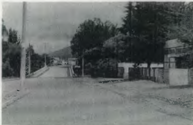
Puente "Las Guzmán" sobre el Boulevard de ingreso de Monjas Jalapa.
