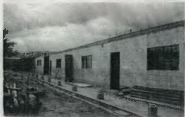
Vista frontal de la escuela Anexa en proceso de remodelación.
