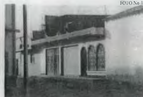
Viviendas situadas dentro de la Quinta Avenida zona 5, entre Calle Tránsito Rojas y Primera Calle de la zona 5. Calle de terracería. La vivienda queda ubicada del lado Oeste de la Quinta Avenida.
