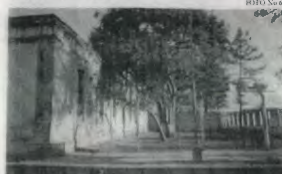
FOTO No 68 Vista de la fachada Oeste del INCAV, así como un muro de ladrillo que divide el jardín Oeste a la fachada que parte desde los baños hasta el centro. Con este muro se divide el INCAV con la Escuela Anexa. Foto tomada desde el ingreso a la Escuela Anexa.
