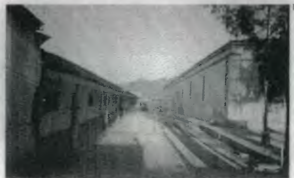
Vista de la escuela Anexa ya remodelada, enfrente la fachada posterior del INCAV y al fondo el área de talleres. Vista desde el ingreso a la Escuela Anexa.
