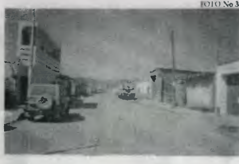
Viviendas ubicadas entre la Quinta y Sexta Avenida de la Calle Tránsito Rojas. Vista de Este a Oeste.
