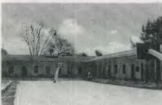
FOTO No 62 Pasillos internos Este y Sur. Primer plano de cancha de basquetball. Techo de durillo y estructura de madera.
