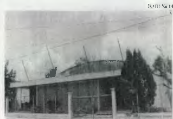
Vista frontal del Auditorio. Muro frontal perimetral de malla y columnas de concreto reforzado y tubos metálicos. Encima del voladizo de concreto se encuentran las astas para las banderas.
