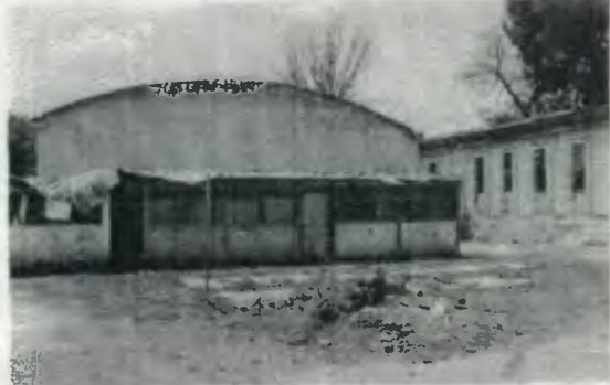
Vista de la parte posterior del auditorio y la fachada posterior Este del INCAV, y en la parte frontal de la foto el cubículo de taller de tres ambientes.
