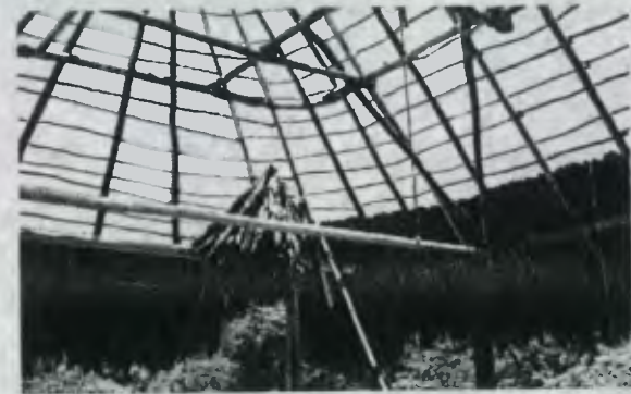
FOTO No.34 COLOCACIÓN DE GUANO EN CUBIERTA CONSTRUCCIÓN UBICADA EN EL MUNICIPIO DE SAN JOSÉ A ORILLAS DEL LAJO PETÉN ITZÁ. / AUTOR: PROPIA.
