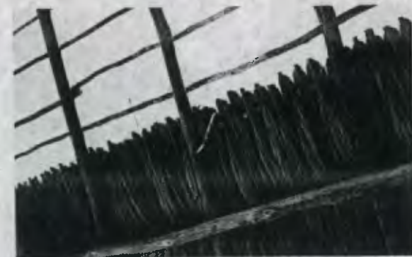
FOTO No.35 DETALLE DE COLOCACIÓN DE GUANO EN CUBIERTA. AUTOR: PROPIA.
